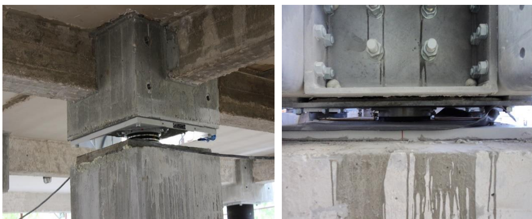
5-сүрөт. Жылма подшипник
