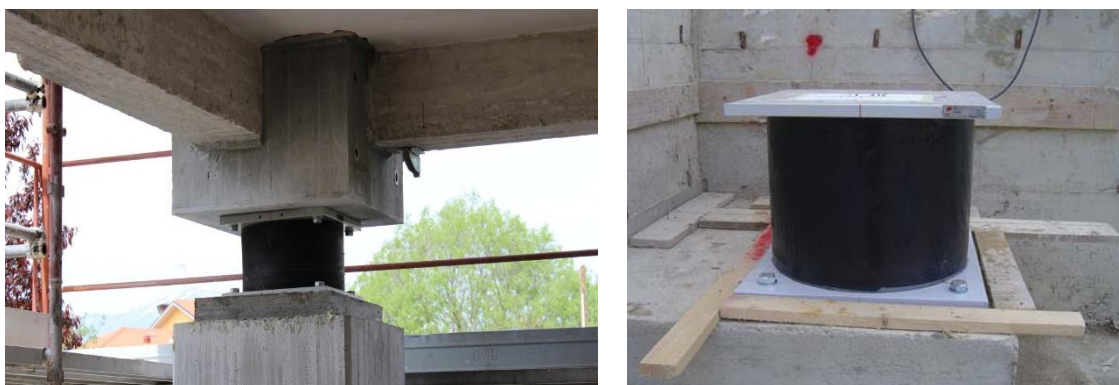
4-сүрөт. Ламинатталган резина подшипник
