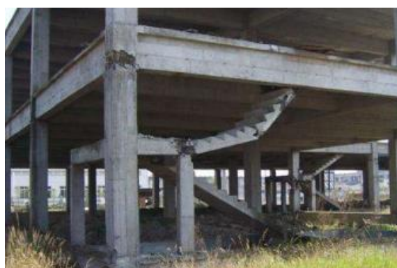
2-сүрөт. Каркас конструкциясындагы тепкичтердин сейсмикалык бузулушу
