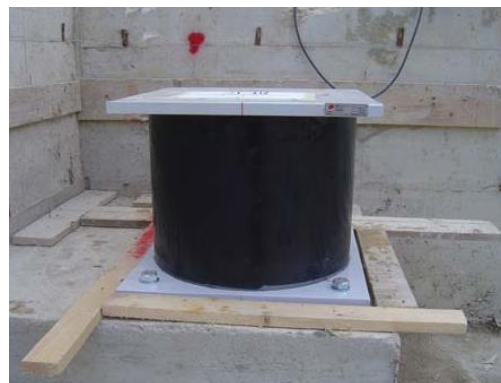
4-сүрөт. Ламинатталган резина подшипник
