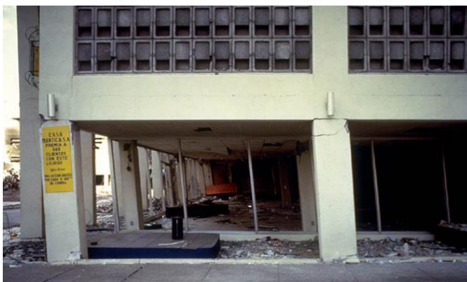
1-сүрөт. Каркас конструкциясынын сейсмикалык бузулушу
