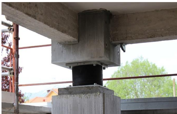
4-сүрөт. Ламинатталган резина подшипник
