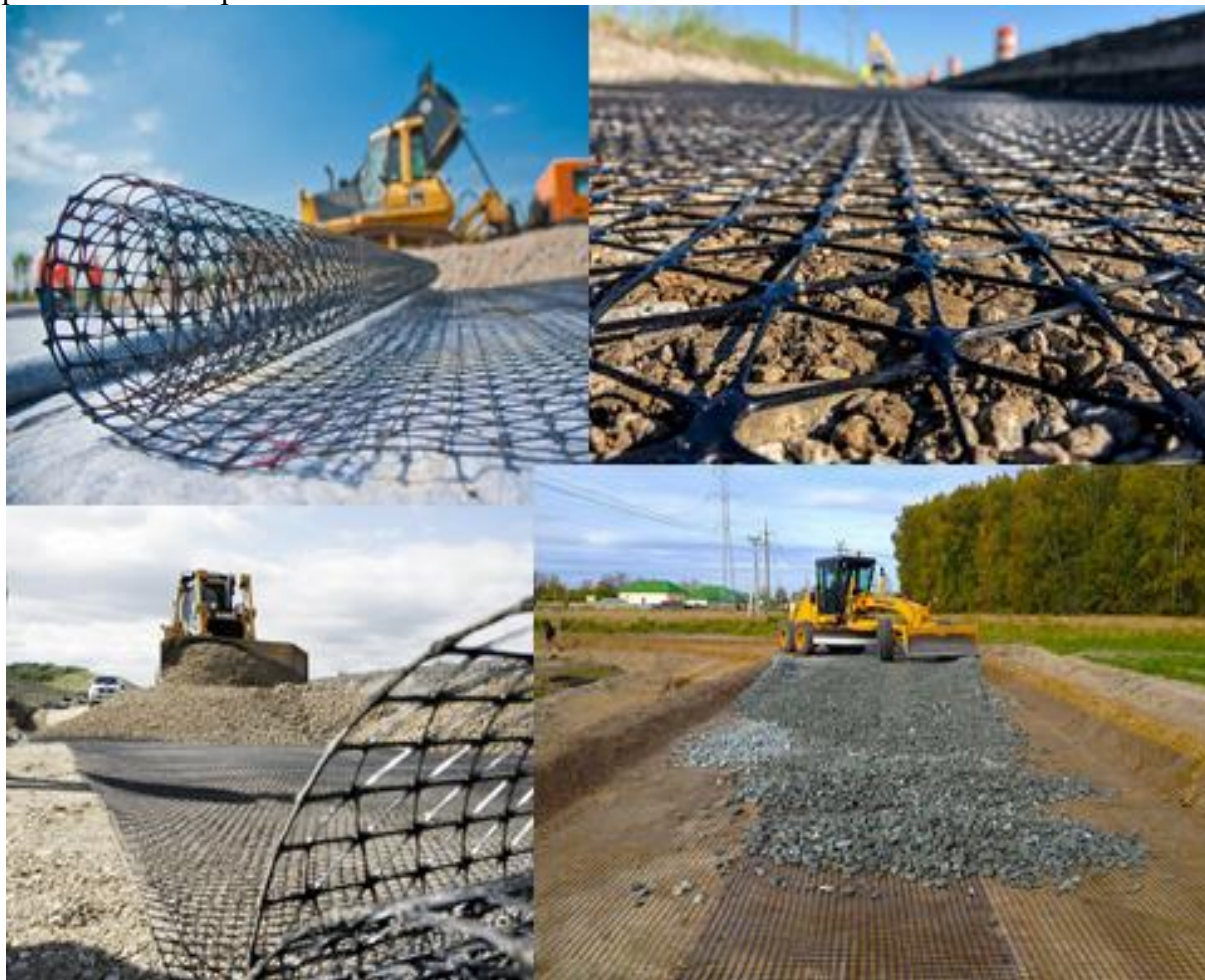
Рисунок 6 - Процесс возведения земляного полотна железной дороги с применением георешетки на болотистом участке.
