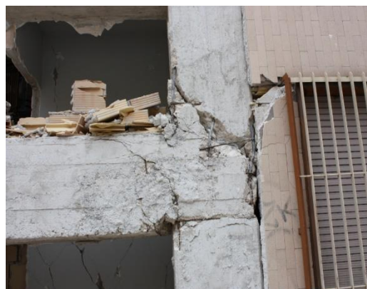
1-сүрөт. Каркас конструкциясынын сейсмикалык бузулушу
