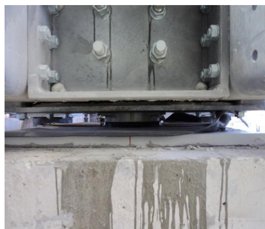
5-сүрөт. Жылма подшипник
